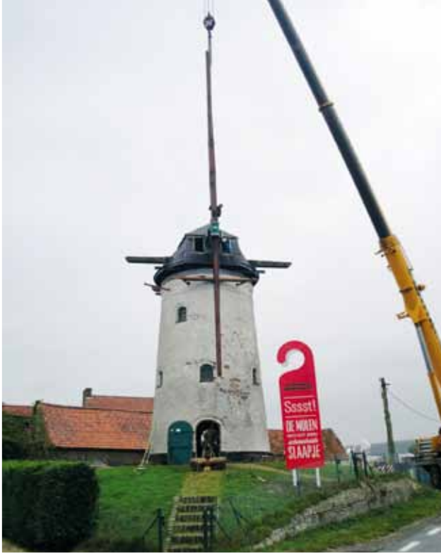
> De kraan verwijdert de molenwieken. De restauratie kan starten [foto: © Herita vzw]
